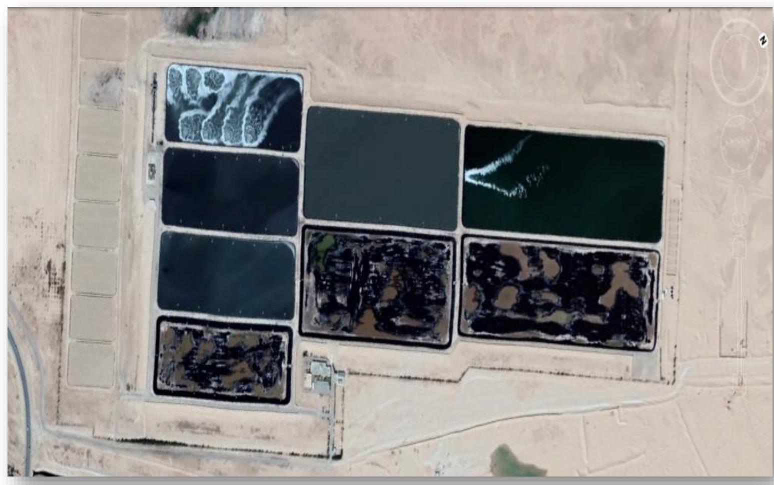
محطة المعالجة مياه الصرف الصحي بسعيد عتبة - ورقلة (STEP)
