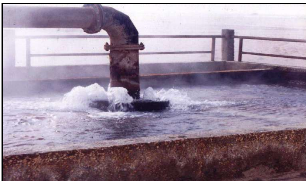
Figure N°39 : Vapeur d'eau dégagée par un forage albien.
