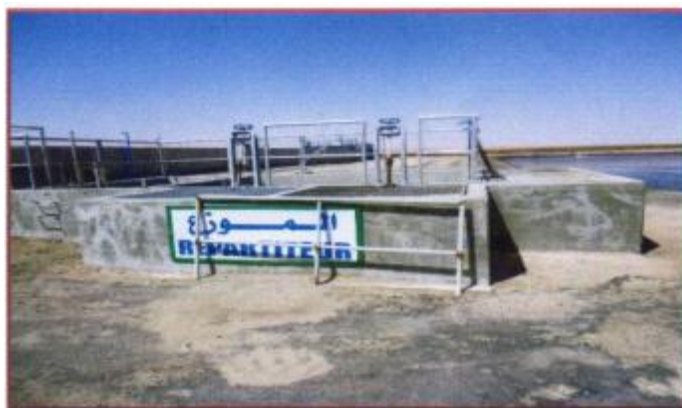
Figure (III-10) : Répartiteur vers les bassins d'aération
