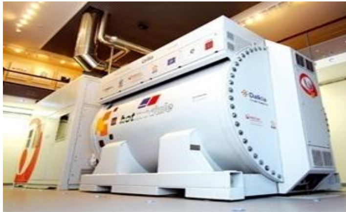
Fig. (III.18) Pile MCFC 250 kW baptisée CELLIA et mise en place par Dalkia dans un HLM à Paris.
