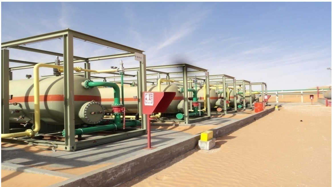
Fig.V.1 : Section de séparation.
