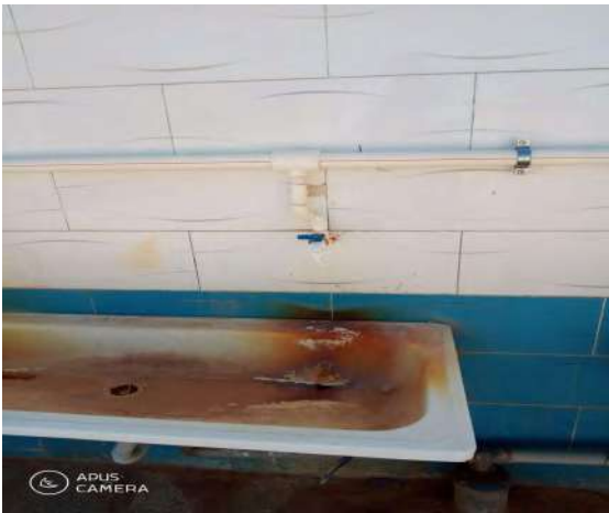
آثار الصدأ نتيجة إستعمال مياه الطبقة الألبينية بالحجيرة
