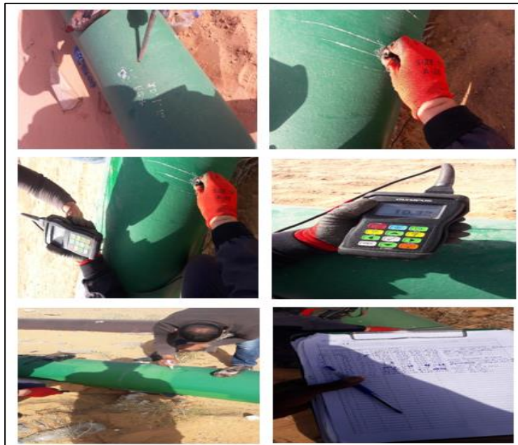
Figure III- 3: Inspection par Ultrason ;
