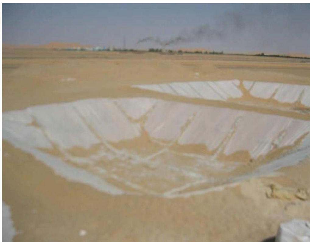
Figure(1.2) :Photo de Bourbiers étanche avant le forage
