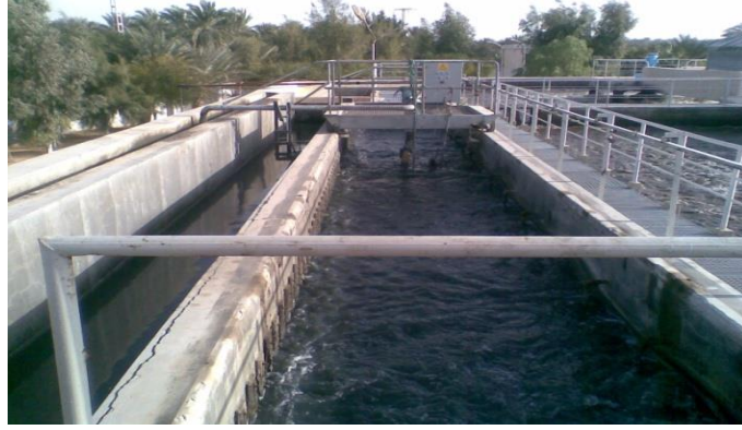
الصورة II-2: صورة توضح آلية نزع الرمال.
