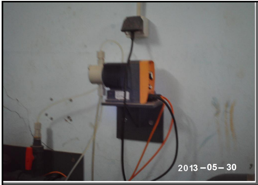
Photo-02 : Pompe doseuse anti-scalant
