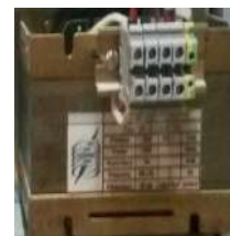
Fig.I.19 : Un transformateur
