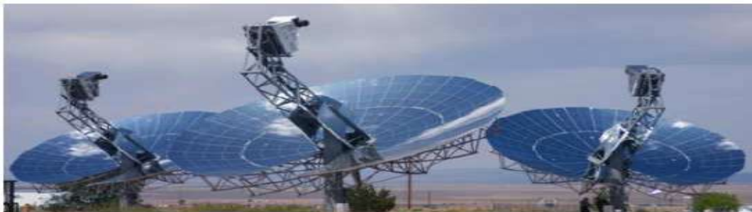
FIGURE 1.12: Centrale à concentrateur parabolique[3]
