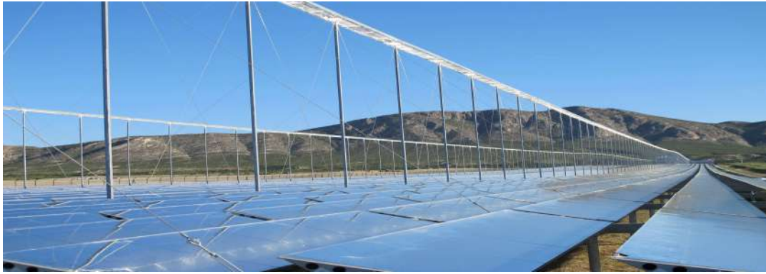
FIGURE 1.11: Concentrateur solaire à miroirs de Fresnel[2]
