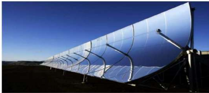
FIGURE 1.7: Concentrateurs cylindro-paraboliques[1]
