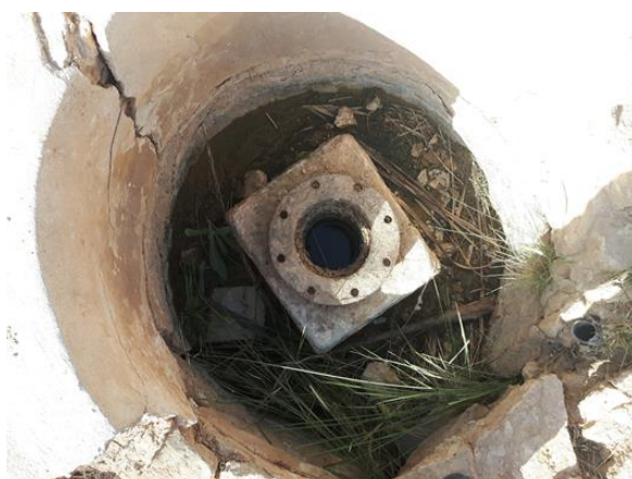
Niveau statique dans un forage à El Menia)
