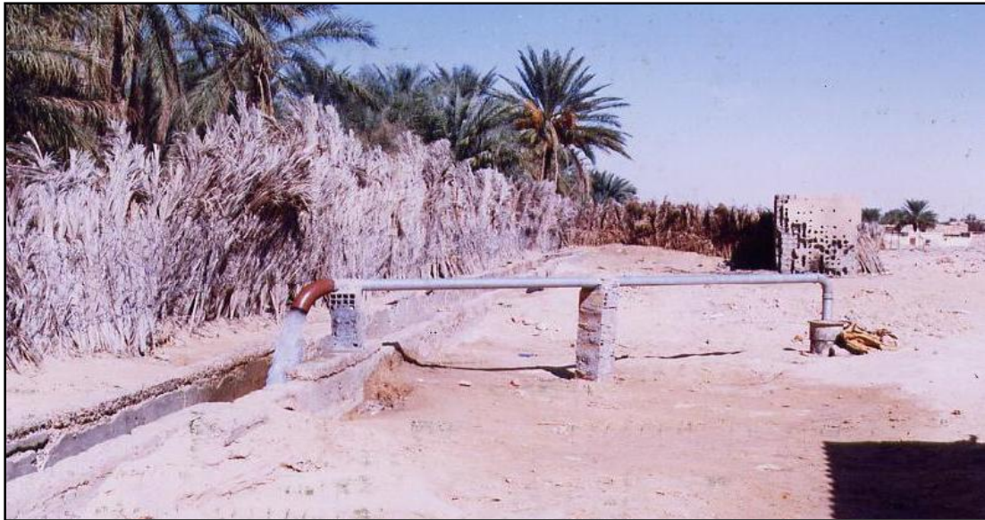
Fig. 21. Photo d'un forage du Complexe Terminale (2 ème nappe) à Sidi Mahdi. (Faycel Hallal 2004.)
