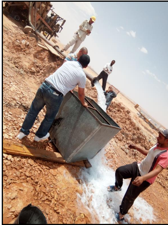
Essai de pompage d'un forage d'eau région de Mansoura
