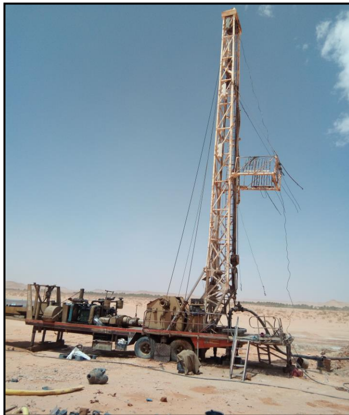
L'appareil de forage hydraulique
