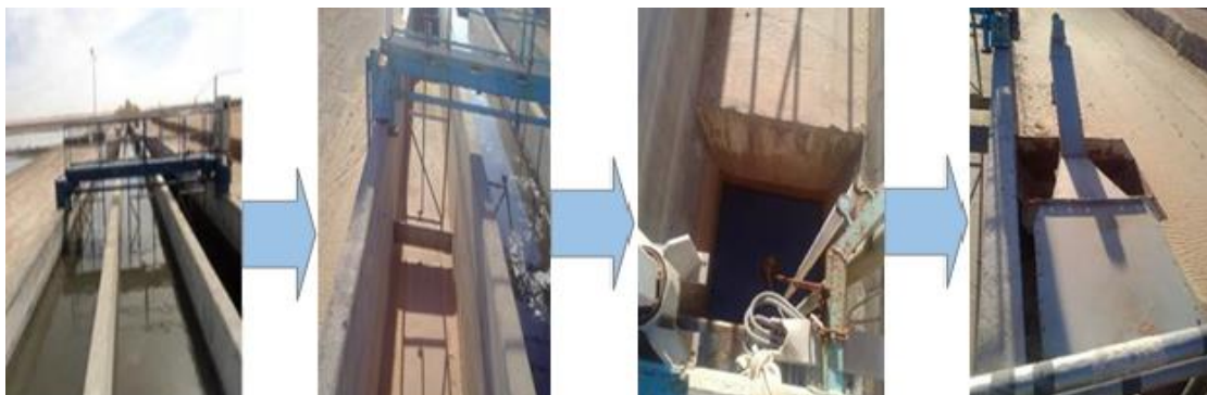
Figure III.5 : Technique de dessablage
