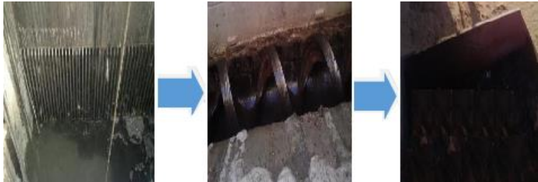
Figure III.4 : Rétention mécanique des déchets
