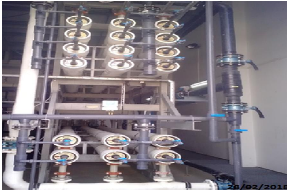
Figure II.11 : ligne d'osmose inverse
