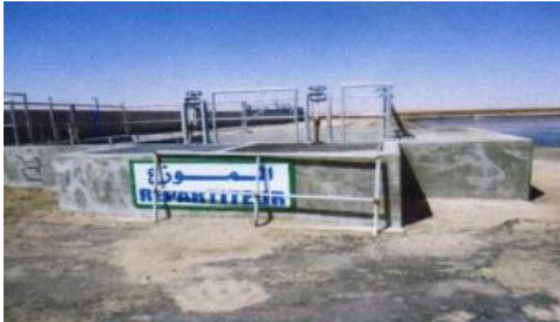
Figure III.6 : Répartiteur vers les bassins d'aération
