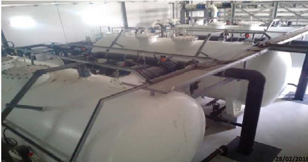
Figure II.5 : Unités des filtres à sable
