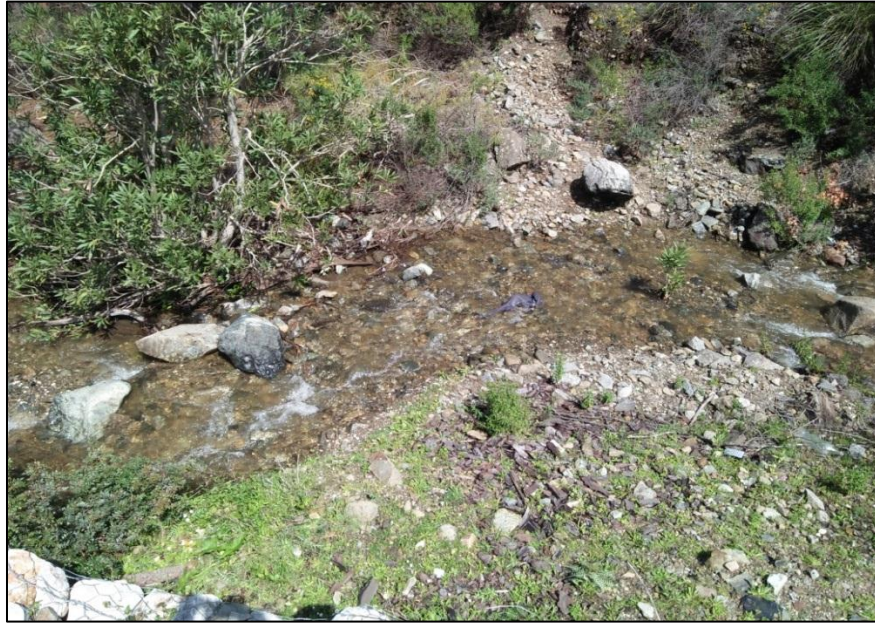
Fig. 14 : Photographie montrant les forces d'écoulement des eaux d'chenal qui alimente l'Oued Tamanart
