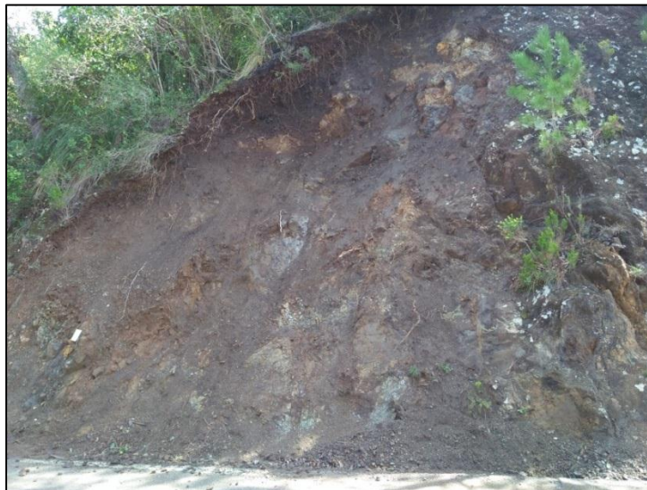
Fig. 18 : Photographie montre le glissement de terrain sous forme de coulée Boueuse affectant les terrains avoisinants de l'Oued Tamanart.
