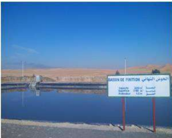
Photo 06: Bassin de finition [30]
