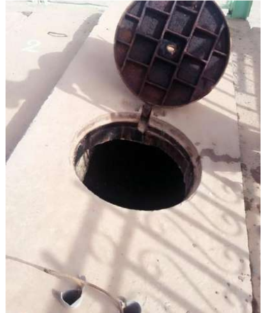
photo N°(11) : Chambre 02
