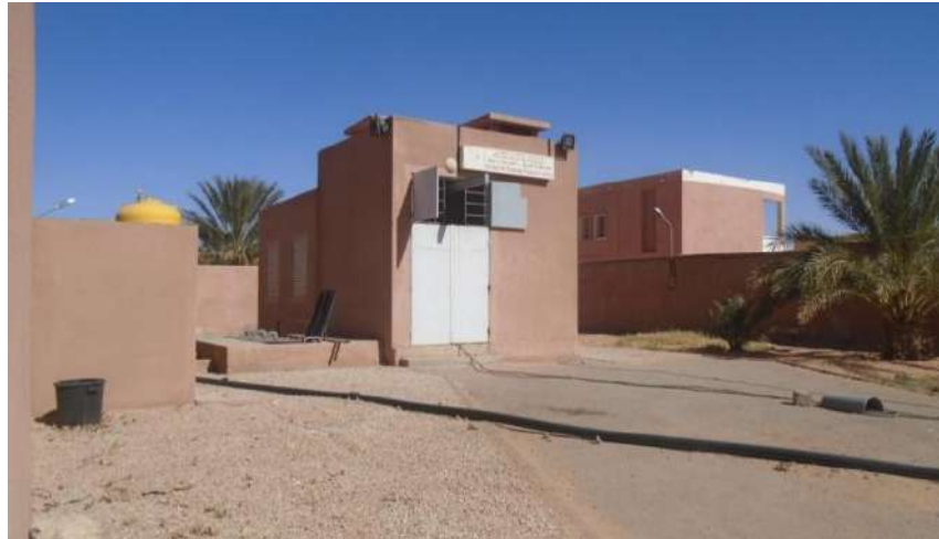
Photo N° (03): Station de pompage
