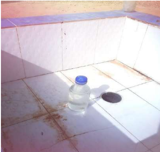
Photo N°(16): Bassin de l'eau traitée
