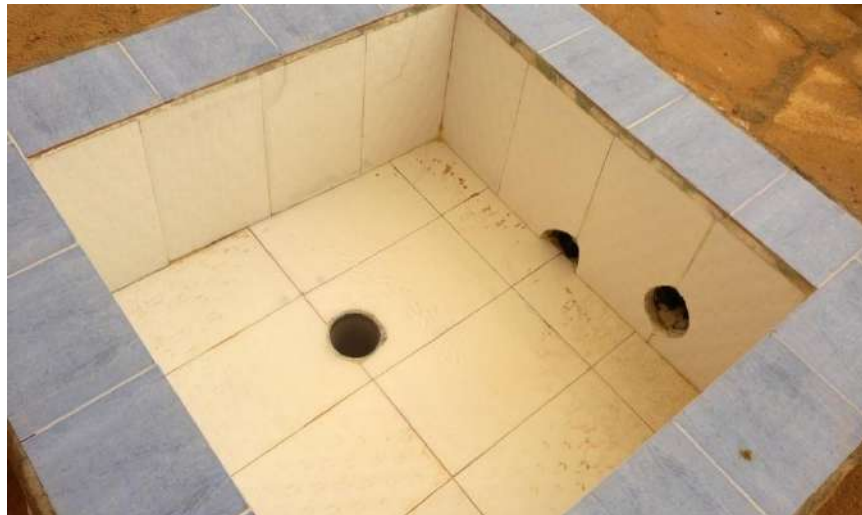
Photo N°(15) : Boîtier de contrôle
