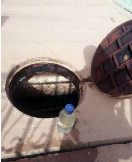
Photo N°(10) : Chambre 01
