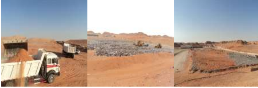
الشكل 3-10: صور التغطية النهائية للأرض بالرمل
