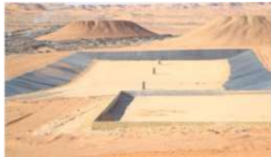
الشكل 3-5: صورة أحد أحواض الظمر التقني (Casier d'enfouissement)
