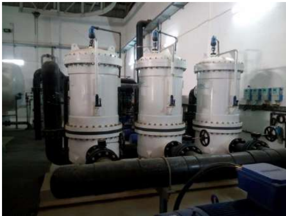
Figure 12: Filtres à cartouches de la station d'IFRI GARA.
