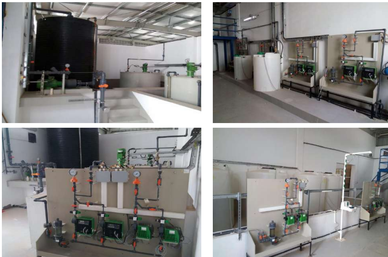
Figure 6: Bâtiment de chloration à la station d'IFRI GARA.
