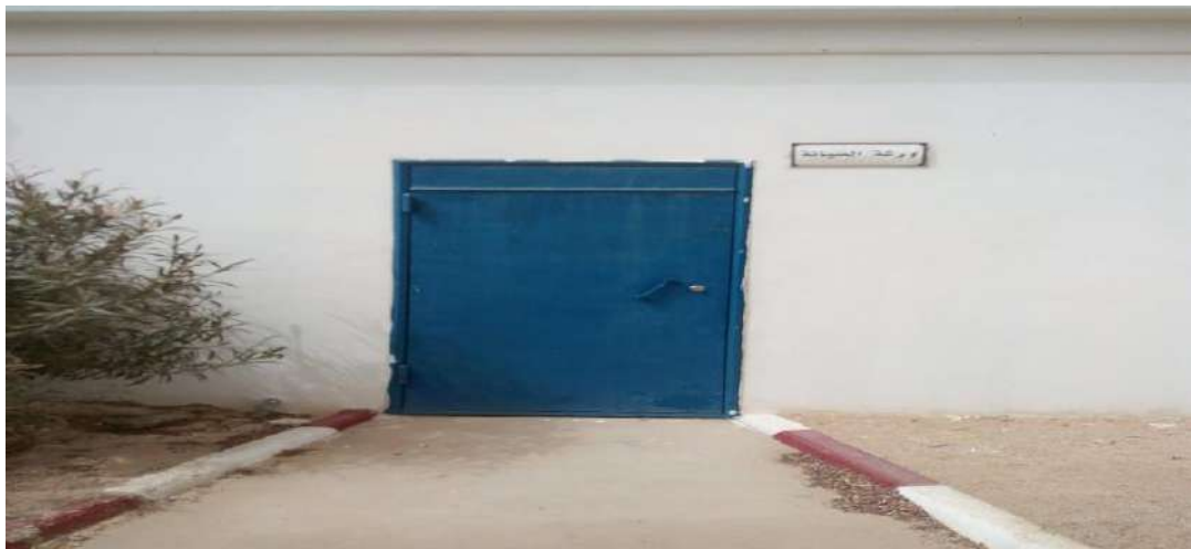
Figure 8 : Bâtiment d'Atelier d'entretien à la station d'IFRI GARA.
