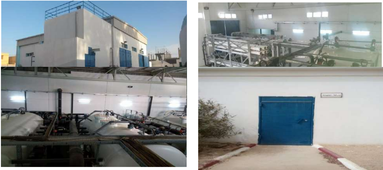
Figure 5 : Bâtiment de traitement de la station d'IFRIGARA.
