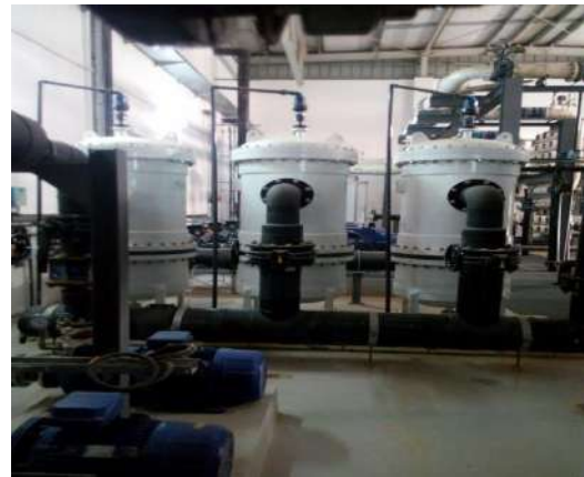
Figure 12: Filtres à cartouches de la station d'IFRI GARA.
