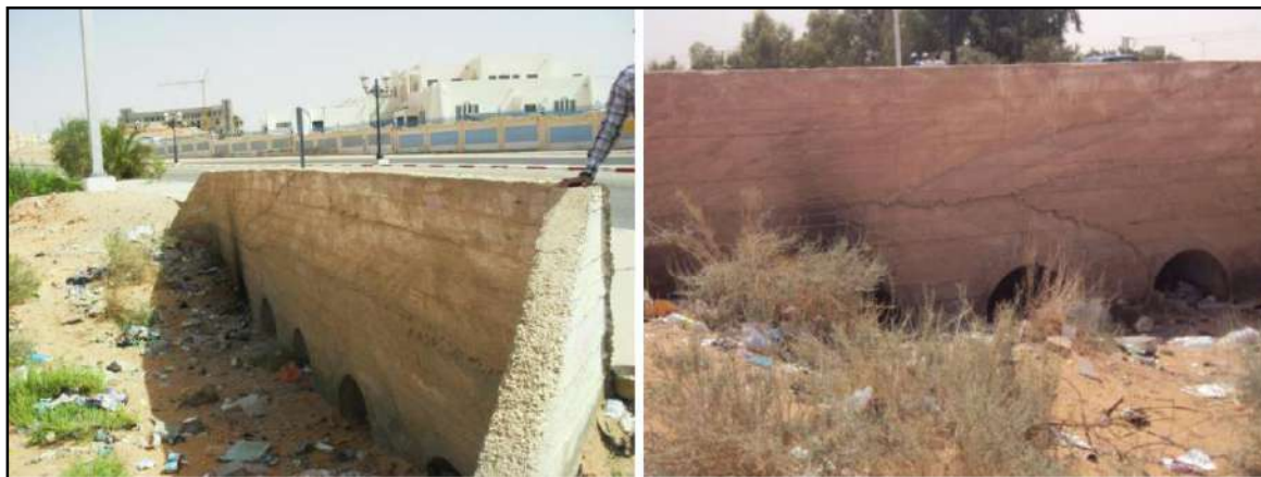
Photo (I.1): l'ancien dalot hydraulique
