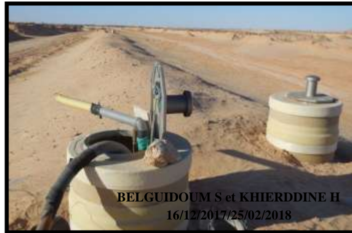
Photo 1. Canal utilisé pour le pompage des eaux usées épurées
