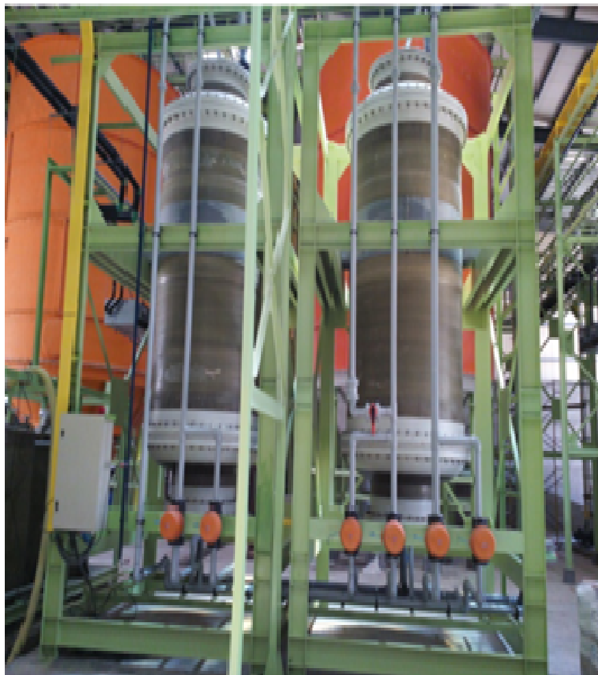
Figure 34. : Filtres à sable
