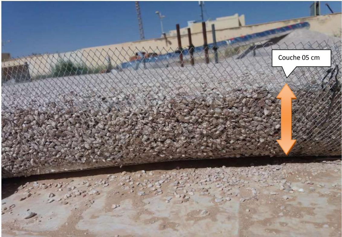
**Fig. III.7:** Couche de gravée concassée 05 cm
