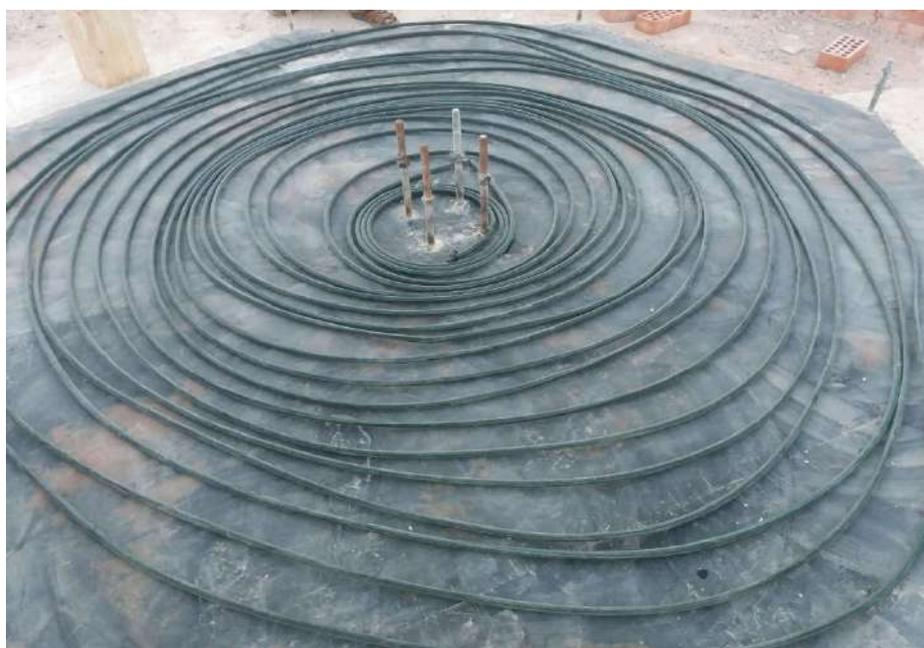
**Fig. III.10:** Tube noire de PVC en spirale
