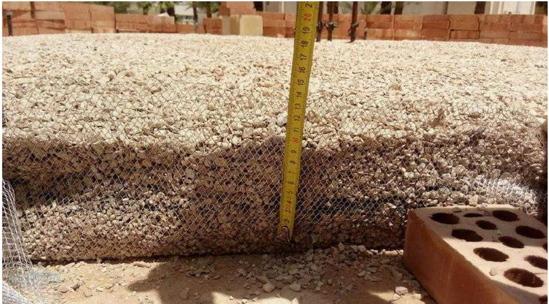
**Fig. III.8:** Couche de gravée concassée 10 cm
