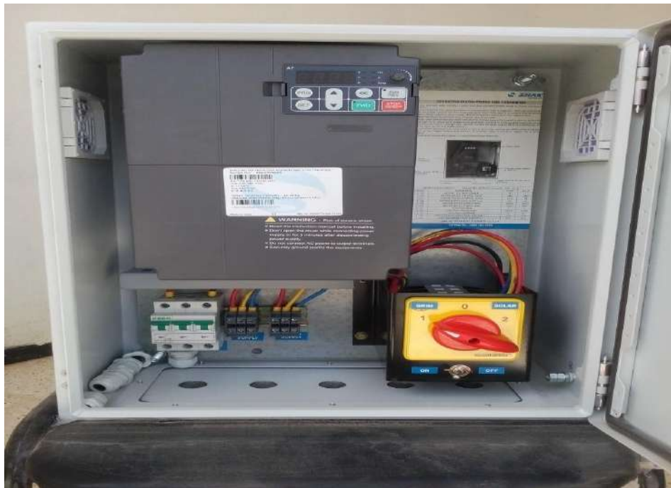
Figure (III.5) : Onduleur DC/AC. [26]
