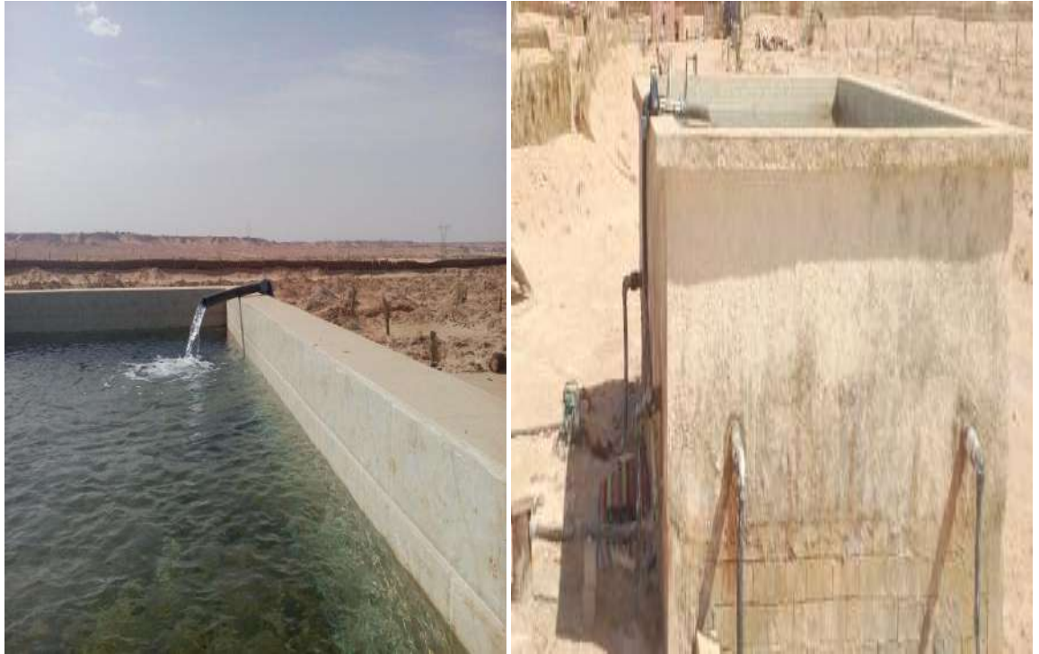
Figure (III.3) : Réservoir de la ferme.
