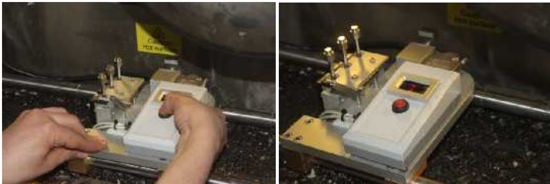
Photo IV.4. Mesure de profondeur d'orniérage.
