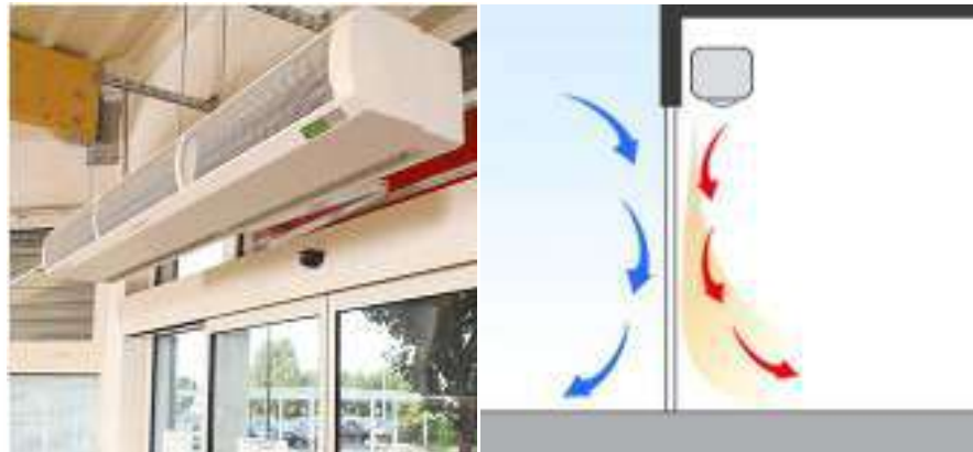
Figure IV. 1 : rideaux d'air des portes
