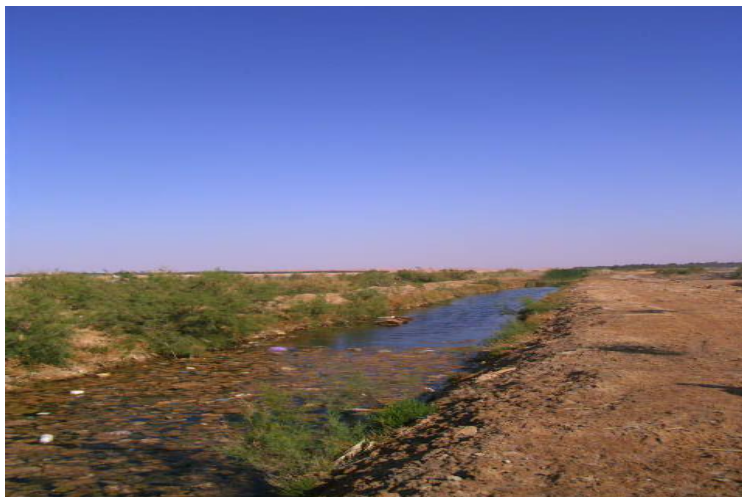
Photo n° 5 : Un drain rempli (en Avril 2011) au niveau du Chott
