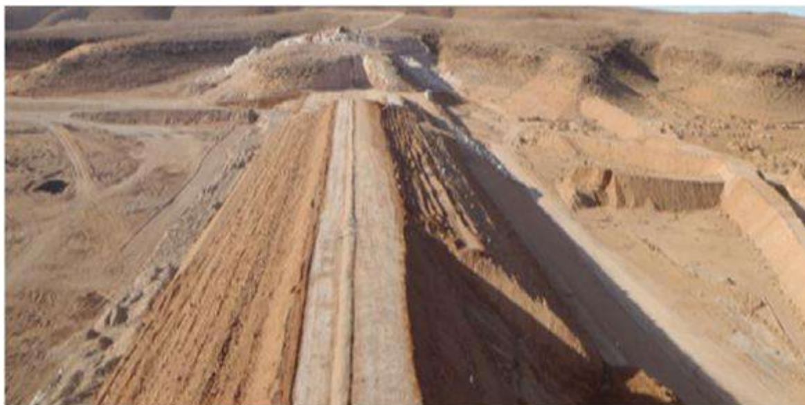
Figure II.10: photo du Barrage El Haimeur
