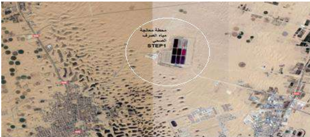
الشكل 10.IV صورة بواسطة غوغل توضح محطة المعالجة بطريقة الأحواض STEP1
