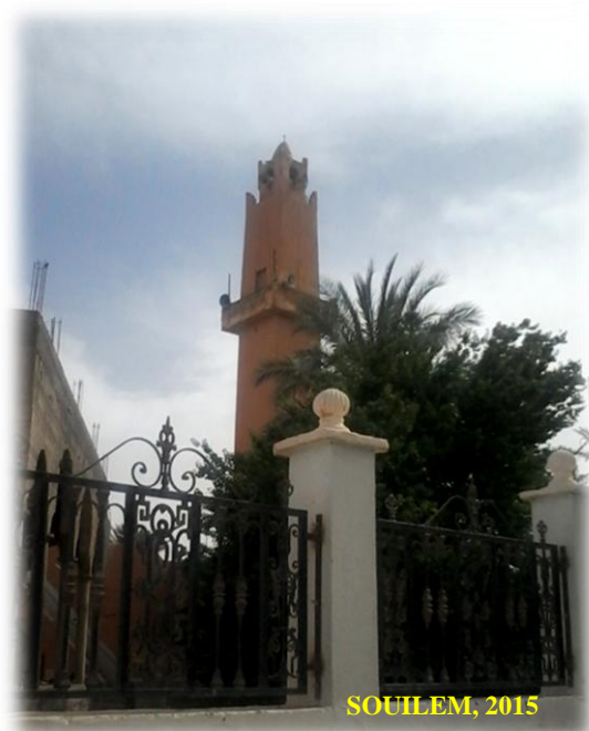
Fig. 4 - Minaret de la mosquée de la station de Daïa Ben Dahoua
