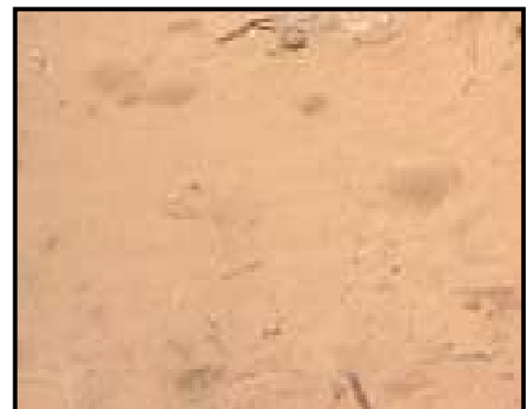
Photo N° 08 : État de la surface pour 2 ème profil.
