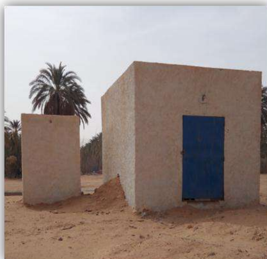
Figure 8: Réservoir d'eau de forage
