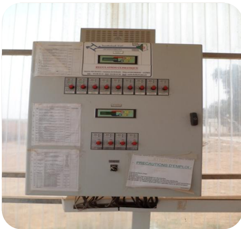
Photo n°03 : Pupitre des données : H%, T°C, Vent, Ensellement, Luminosité(L).
