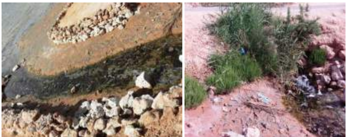
Fig. 31: Evacuation les eaux usées et les eaux urbaines domestiques dans les lacs et les chotts
