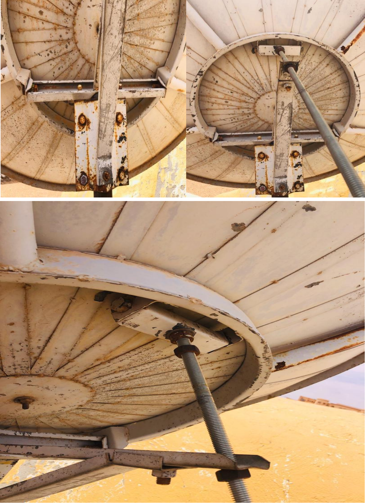
الشكل II-24: صورة لنظام التتبع الذي يحتوي على اسطوانة ومحور دوار
