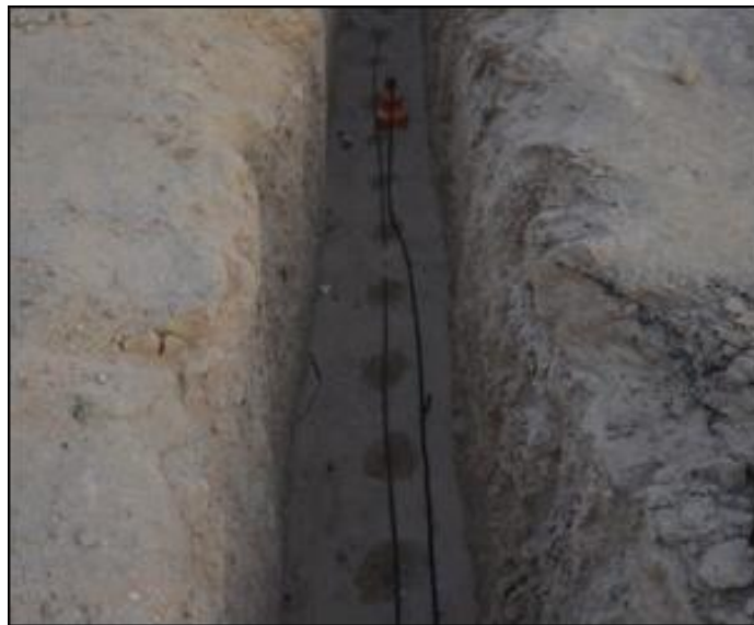
Fig3: Installation et test du réseau hydratant [7]
