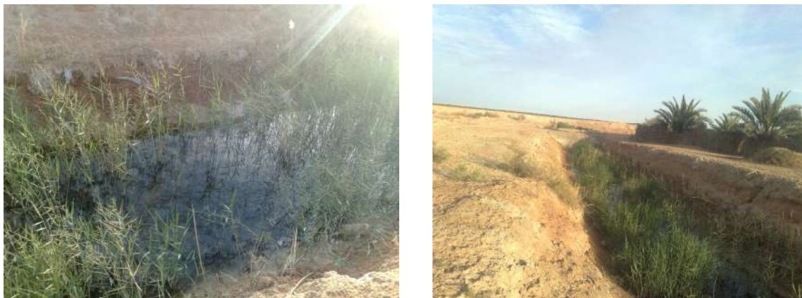
Photo 06 : Réseau du drainage
