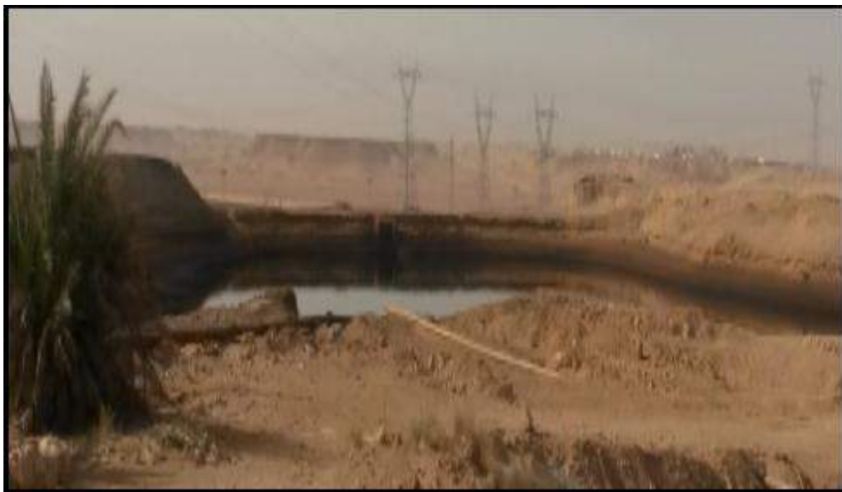
Figure (14) : Bassins d'évaporation.
