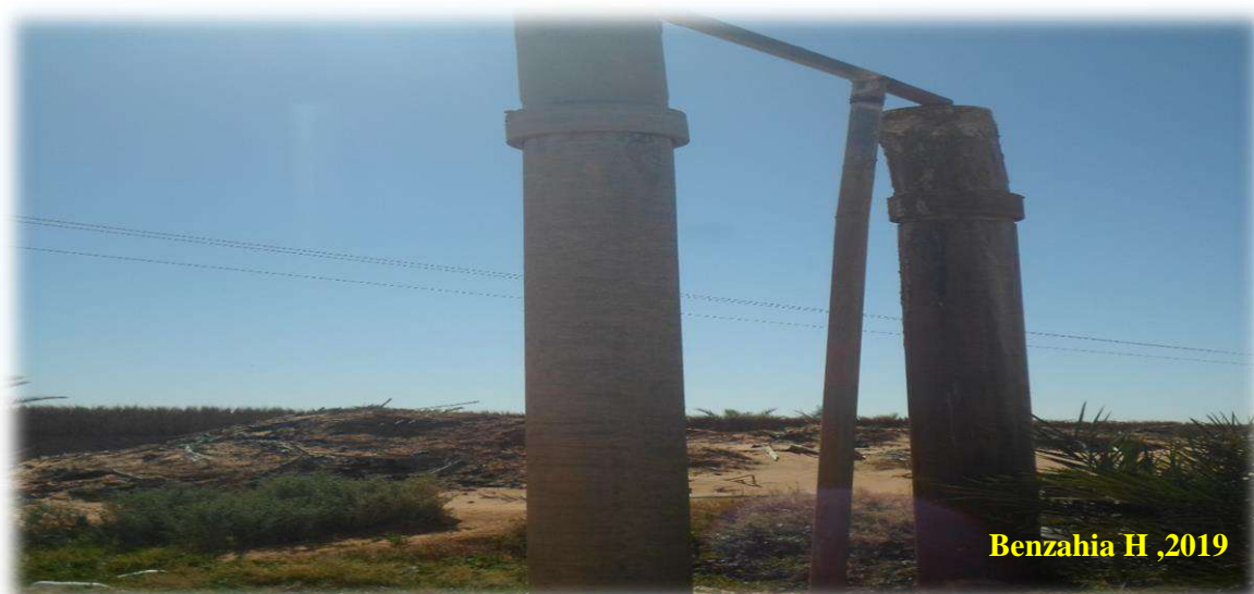
Photo n°16 : le forage d'irrigation
