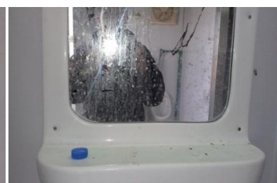
c-miroir de la douche impropre
