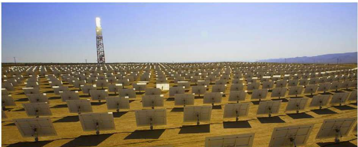
Figure I.2 : Centrale à tour
