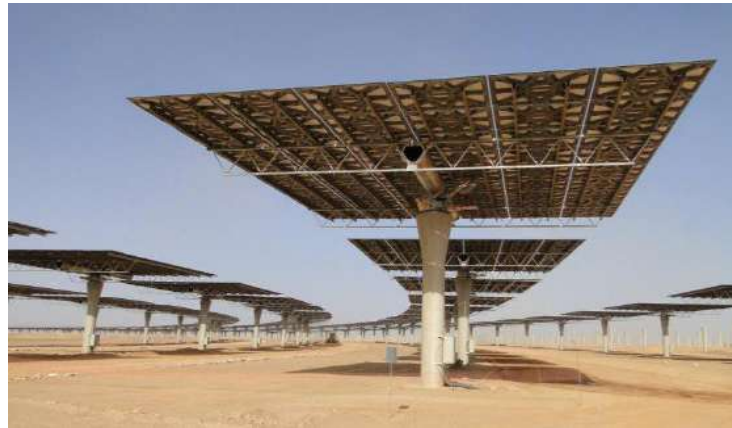
Figure II.18 : Héliostat de SENER de 175.7 m 2 [29]
