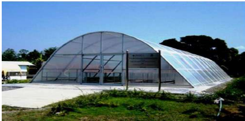
Figure I-13 : Séchoir de type serre à grande échelle avec brûleur GPL [Janjai et al, 2011].
