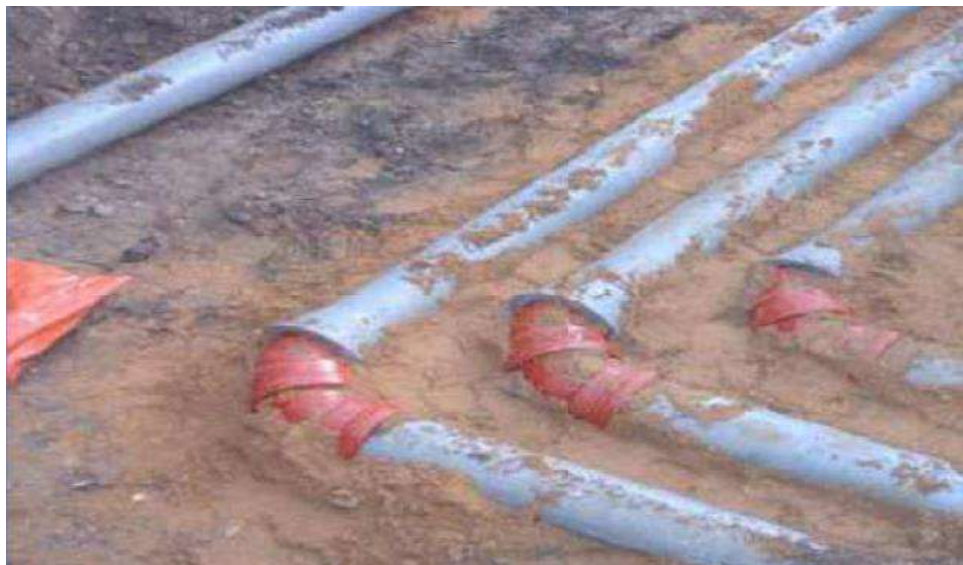
Figure (II.12) : Echangeur géothermique.
