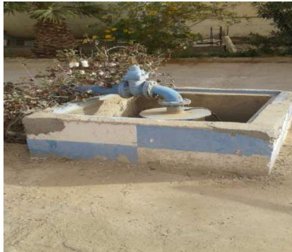
Figure -14- : Forage d'eau
