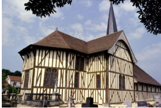
Figure I.6 : Construction en torchis[14]
