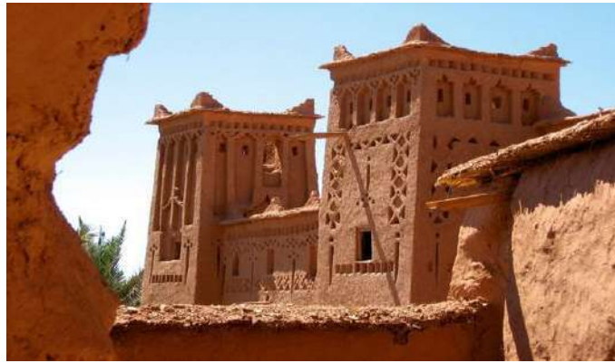
Figure I.3. Ancienne construction en pisé [10]
