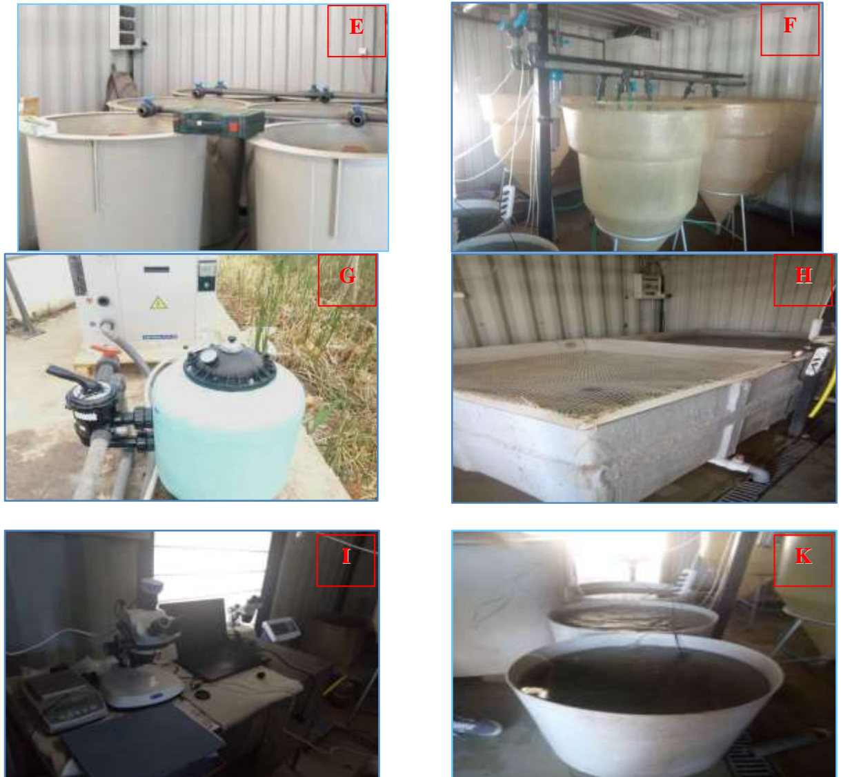
Figure 10. Equipements de l'écloserie de la station Ouricia (A : Système d'alimentation en eau ; B : Système de filtration ; C : Système d'évacuation de l'eau ; D : Bouteilles de Zoug ; E : auges d'élevage larvaire ; F : Bassins de post-élevage ; G : Thermorégulateur ; H : Bassons de géniteurs ; I : Table de laboratoire ; J : bacs d'incubation des œufs du sable).
