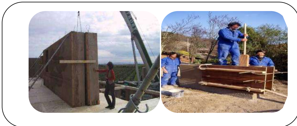
Figure I.4 Construction d'un mur en pisé [6]
