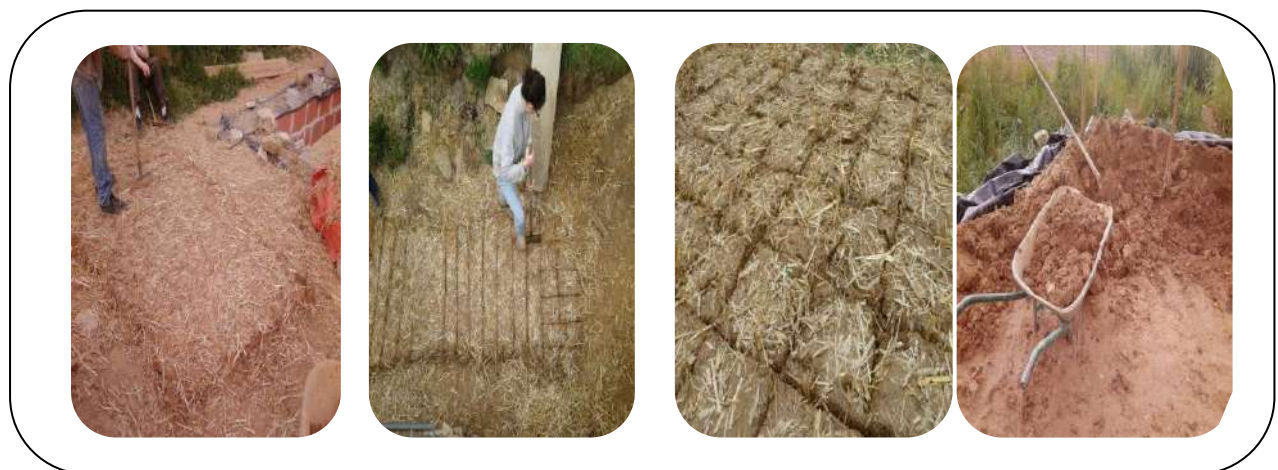
Figure I.5 Les étapes de la préparation de la bauge [8]
