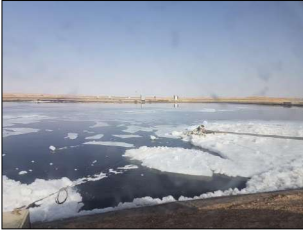
Figurei IV.11: bassin d'aération
