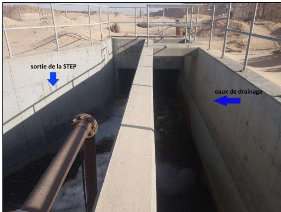
Figure IV.15: canal d'évacuation vers sabkhat safion
